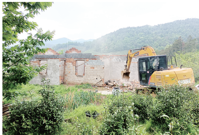
桐城市龙眼街道凤形村结合人居环境整治提升工程,推进无功能建筑物拆除工作,并对清理出的空地,通过建设公用设施、绿化提升等方式进行环境美化,提高群众的幸福指数。
