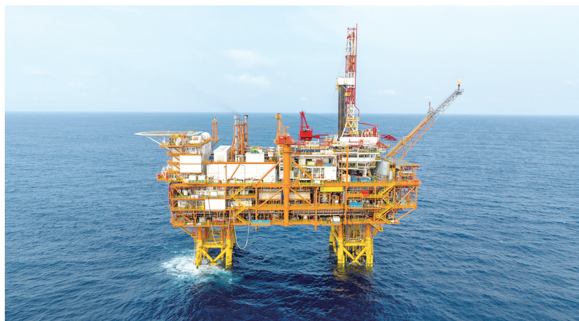
6月1日拍摄的中国海油恩平15-1原油钻采平台(无人机照片)。新华社记者 毛思倩 摄
