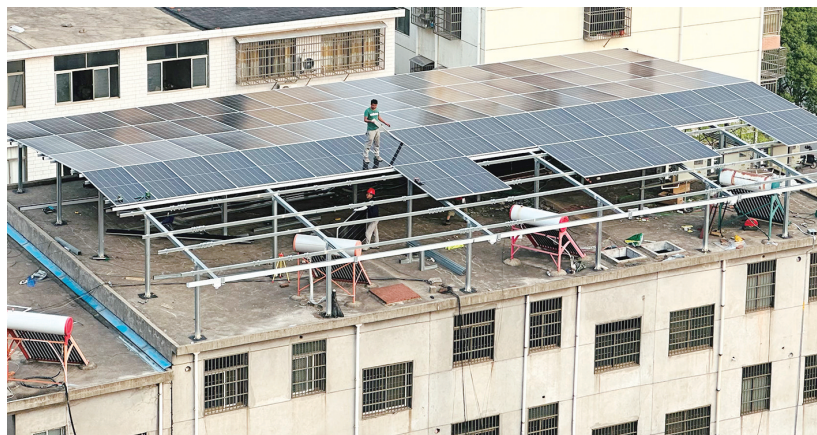
6月4日,怀宁县高河镇一户居民正在屋顶安装光伏。近年来,绿色生活理念已被该镇广大群众接受,越来越多的城乡居民利用自家屋顶建设光伏发电设备。这样,不仅能节省电费开支,增加收入,还能起到隔热、避雷的作用,实现一装多用。 通讯员 檀志扬 刘晓勇 摄
