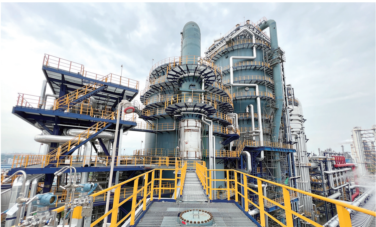
安庆石化转型发展项目重油催化裂解装置6月30日投产。 通讯员 闫谋镇 摄
