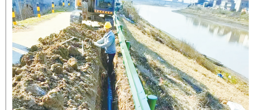
供水管网改造升级施工中。通讯员 汪思恩 摄
