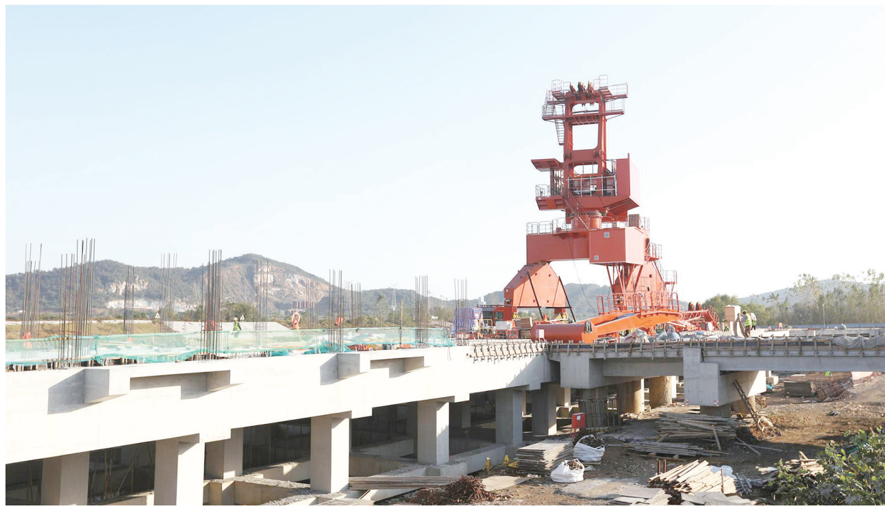
石门湖一期工程项目现场。全媒体记者 徐火炬 摄
