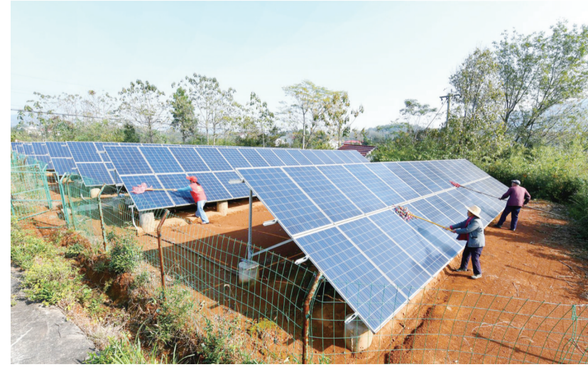
11月14日,宜秀区五横乡白林村邓冲组光伏电站内,党员志愿者杨冬梅在帮助脱贫户吴六元、杨木兰清洗光伏面板。该光伏电站年发电量达6万度,年发电收益4万元左右,不仅增强了村集体经济“造血功能”,同时通过开发公益性岗位,带动周边9名脱贫村民增收。 全媒体记者 黄有安 通讯员 杨安丽 摄
