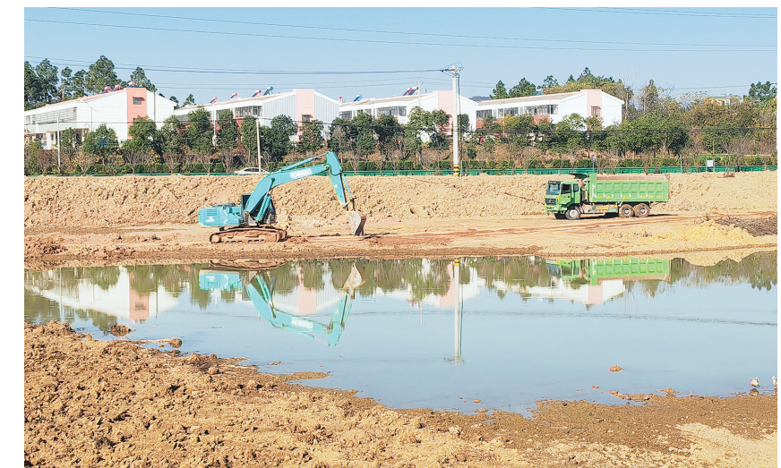
11月20日,怀宁县高河镇太板村组织机械兴修当家塘。入冬以来,该县发动群众参与水利冬修和设施维护,为来年春耕灌溉,农业增收打基础。 通讯员 檀志扬 摄
