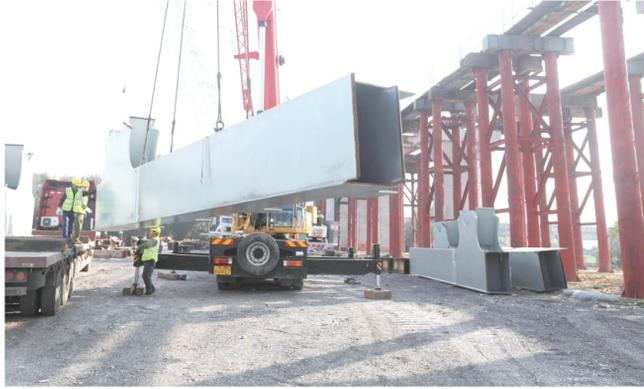
施工人员正在进行钢桁梁拼装作业。 全媒体记者 徐火炬 摄
