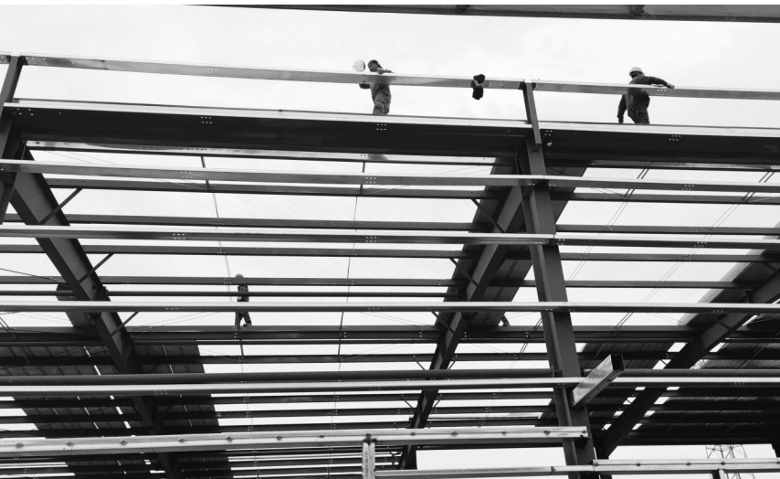
12月14日,在怀宁县江镇镇蒸笼产业园内,工人正在忙着安装架设钢结构构件及安全平网铺设。
