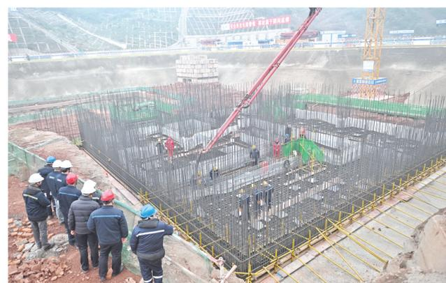
这是1月30日拍摄的医用同位素试验堆施工现场。当日,由中国核动力研究设计院设计、建造的全球功率最高溶液型医用同位素试验堆在四川乐山夹江正式开工建设。据了解,该医用同位素试验堆投运后,可实现钼-99、碘-131等两种医用同位素分别达到10万居里和2万居里的年生产能力。
