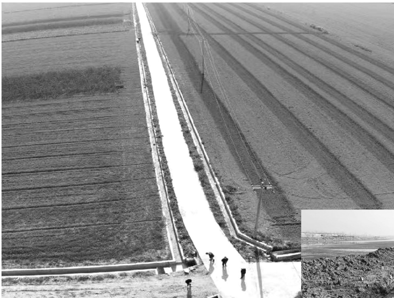
▲新洲灌区硬化提升后的干渠 ▶七号套河套治理施工现场
