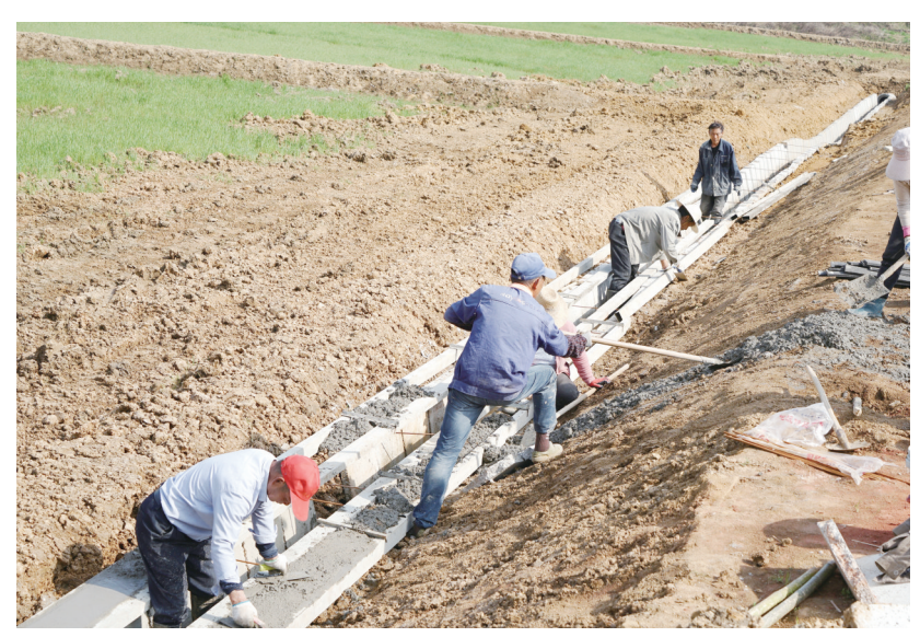
4月6日,在怀宁县马庙镇泥河村高标准农田建设现场,工人正在忙着施工。该县抢抓农时,加快实施高标准农田建设,筑牢乡村振兴“根基”,为农田增效、粮食增产夯实基础。 通讯员 檀志扬 丁浩浩 摄
