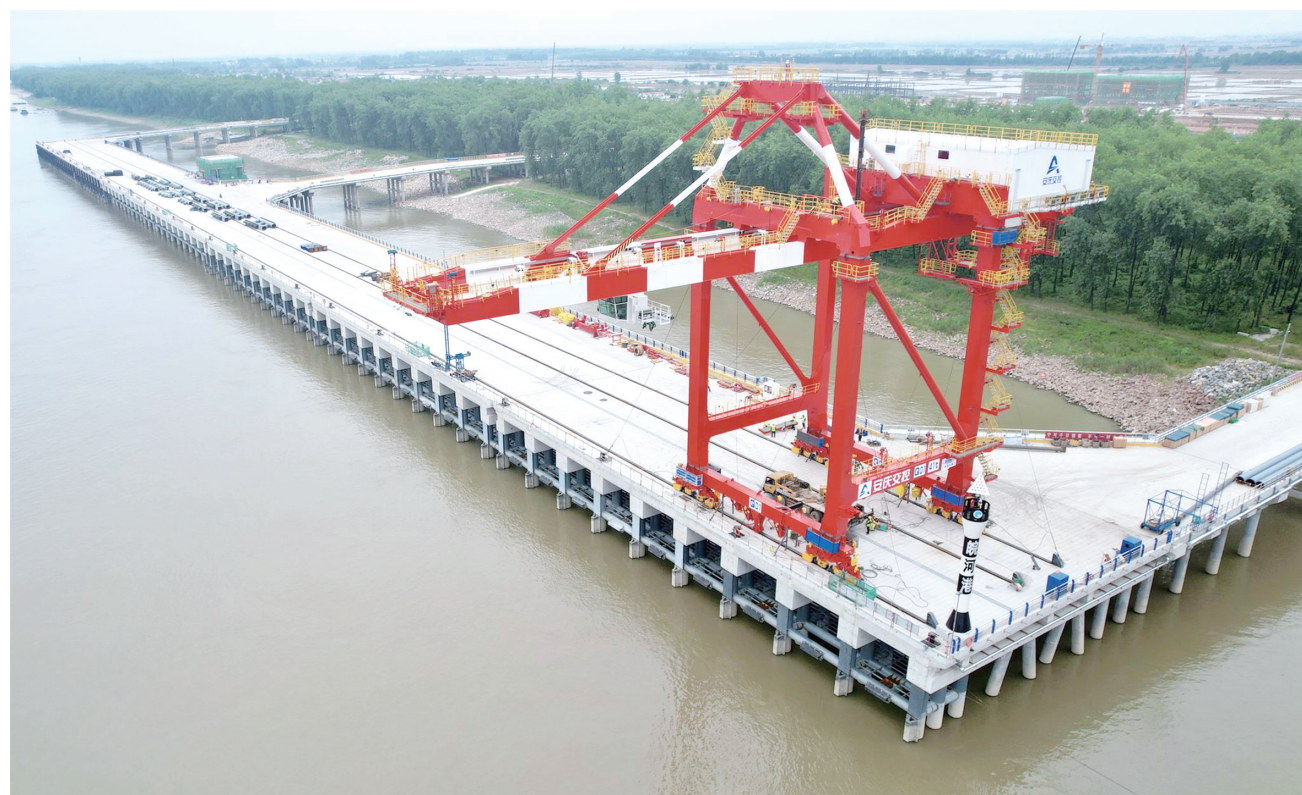
6月7日上午，皖河新港一期工程建设现场。全媒体记者 徐火炬 摄
