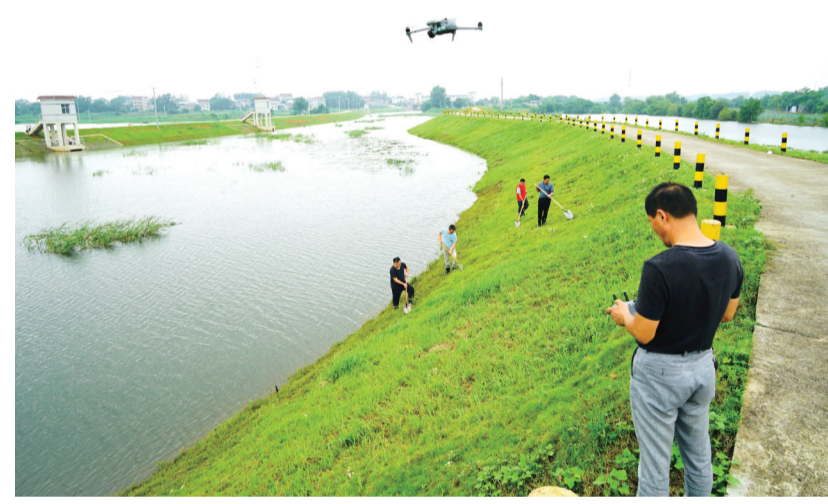
6月24日,怀宁县石牌镇防汛人员利用无人机巡堤查险。该镇通过空地联防、人机结合的巡检模式,高效排查河堤险情隐患。通讯员 程志扬 潘成谊 摄
