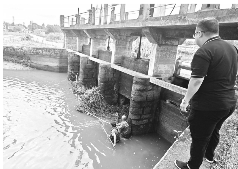
连日来,桐城市新渡镇21个村抢抓时机,检查辖区沟渠涵闸,清除阻水杂物,确保涵闸启闭顺畅,保障安全度汛和后期农田排灌。
