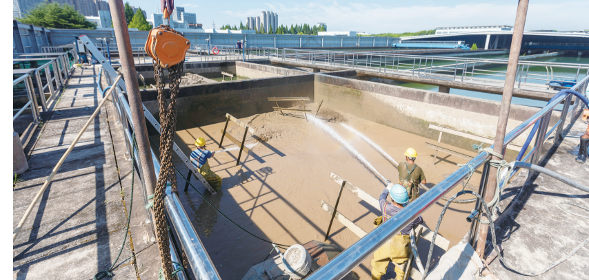
工人们顶着烈日冲洗反应池，以保障出厂水质达标。
