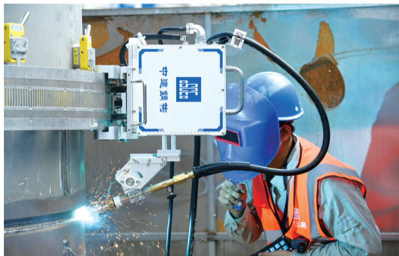
9月5日,工作人员遥控智能焊接机器人进行焊接作业。
