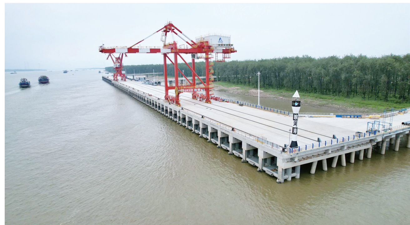
皖河新港一期(码头平台及汽车引桥)通过交工验收。 通讯员 赵军 摄
