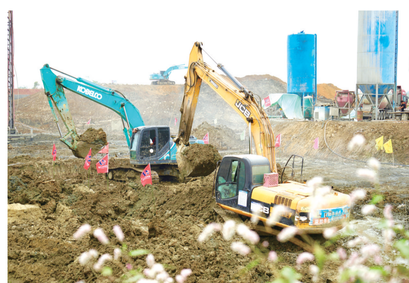
10月15日，位于怀宁县石牌镇的万全电排站工程工地上，挖掘机正在紧张施工。该工程为市级重点工程，总投资近4000万元，排涝面积为19.86平方公里，2024年3月开工，工期为15个月。（通讯员 檀志扬 潘友谊 摄）
