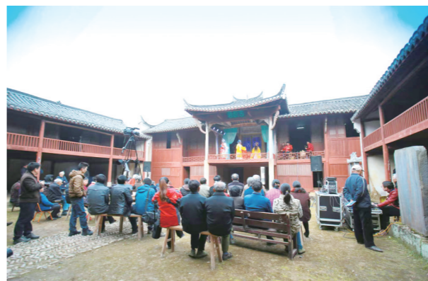
潜山市万洞村杨家祠堂古戏楼在修缮后变成了露天剧场。
