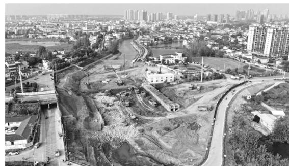
10月17日,在望江县宝塔河网站工程建设现场,施工单位正抓紧实施老闸拆除,现场一片忙碌景象。总投资11450万元的望江县宝塔河网站工程,位于宝塔河和新东隔堤交叉处,由原有宝塔河泵站和城关节制闸拆除合建而成,泵站总装机2400千瓦,总工期365天。该项目建成后,防洪标准将由现在的20年一遇提高到50年一遇的标准,在汛期来临时,能够极大提高望江县城的防洪能力;在非汛期时,也能够从华阳河对宝塔河进行补水,从而有效改善城区的水环境。
