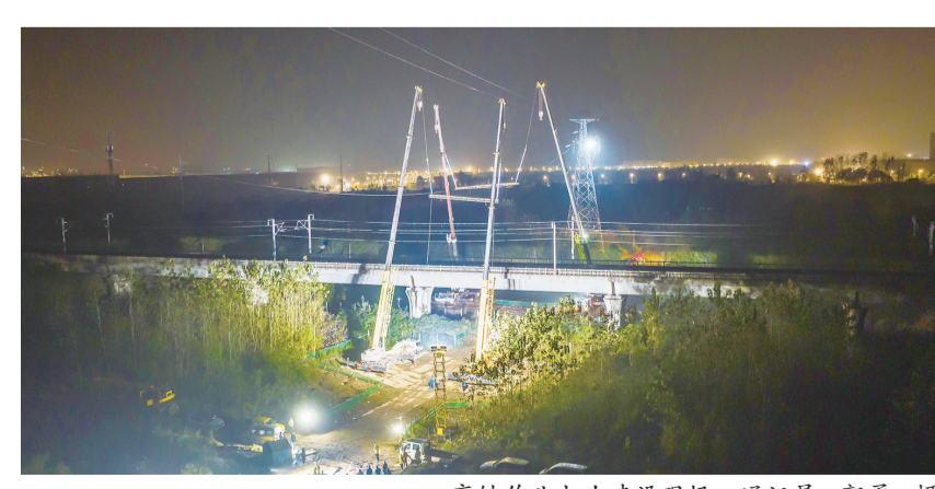
高铁作业电力建设现场。通讯员 郭勇 摄
