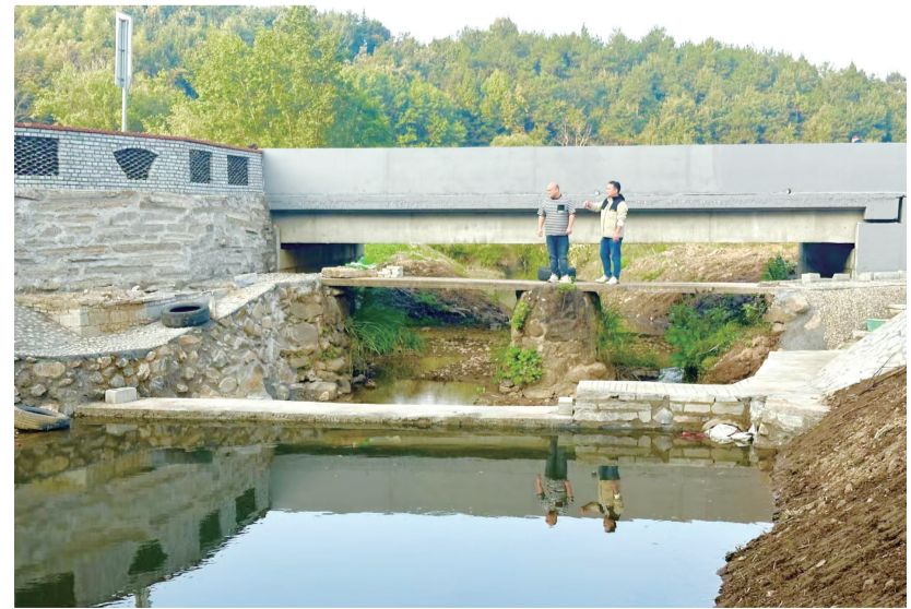
怀宁县石镜乡结合人居环境整治，在虎形组新桥上游边兴建一座长15米、宽4米的拦水坝，保障了下游近千亩良田的灌溉用水难题。
