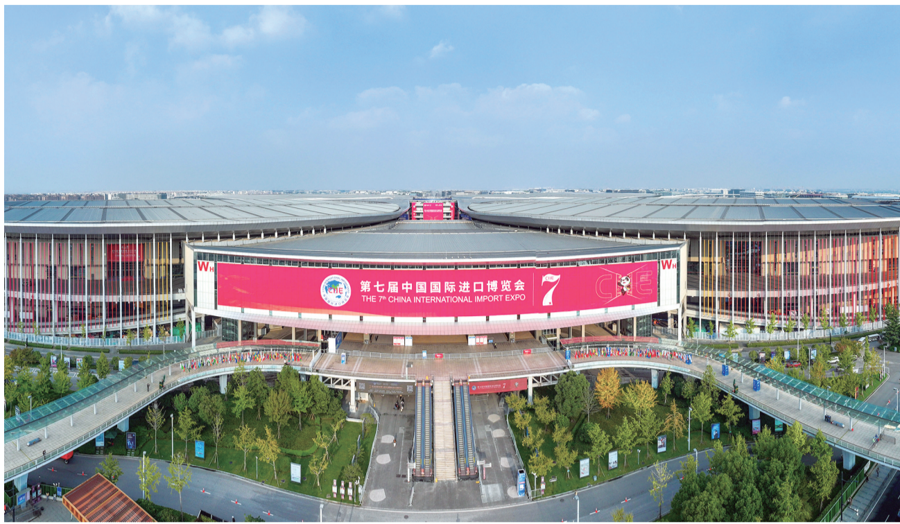
11月2日拍摄的上海国家会展中心(上海)西入口。第七届中国国际进口博览会的举办地——国家会展中心(上海)已完成外部装饰及绿化、接待宴会。
