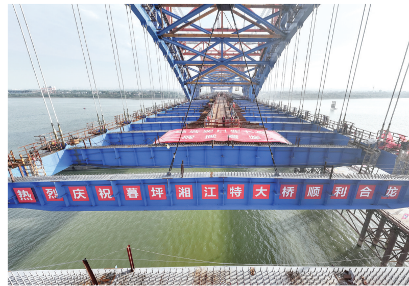
这是11月26日拍摄的长沙暮坪湘江特大桥合龙施工现场(无人机照片)。当日,随着主跨合龙段最后一段横梁安装完成,长沙暮坪湘江特大桥顺利合龙。据了解,暮坪湘江特大桥是连接长沙城南片区与大王山片区的快捷通道,由长沙城市发展集团有限责任公司投资建设、湖南路桥集团承建。项目建成后将为沿线提供便捷的交通条件,促进长株潭都市圈的发展。
