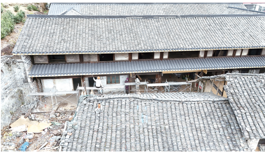
正在修缮中的唐湾古民居。 通讯员 沈世贵 摄
