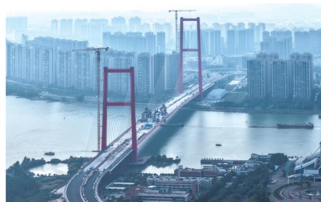
12月24日,由中交路建承建的顺德大桥顺利合龙。位于广东省佛山市顺德区的顺德大桥是主跨626米的超大跨径钢混组合索塔斜拉桥,建成后将有效打通顺德融入粤港澳大湾区“一小时交通圈”的内部区域道路瓶颈。
