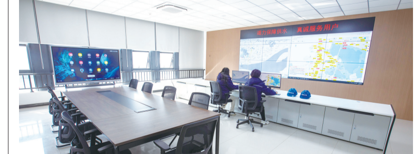
1月16日,工作人员正在监控供水管网压力、流量等实时信息。颜春骏 摄
