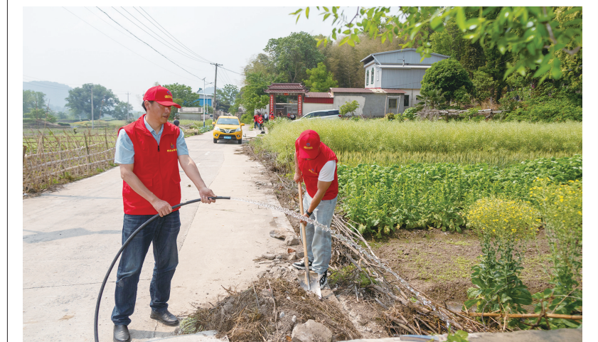
施工人员正在清洁施工路面。 通讯员 顾春骏 摄
