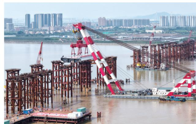
4月29日,1200吨大型浮吊将重达606吨的首节钢箱梁吊装架设在万龙大桥钢架支架上。当日,世界最大跨度自锚式悬索桥——万龙大桥首节钢箱梁架设成功。
