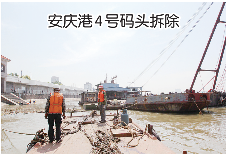
安庆港4号码头拆除现场。华丛发 徐火炬 摄
