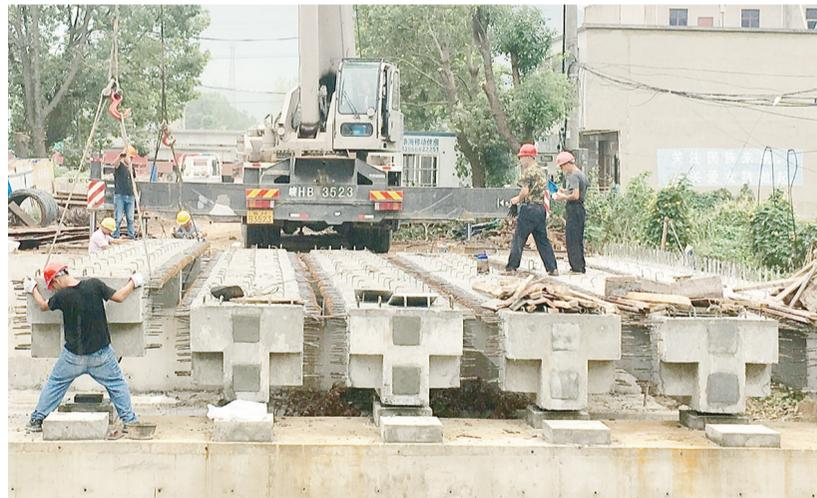
9月1日,工程技术人员正在铺设桥面。怀宁县月山镇大桥危桥是连接月山老街到206国道的一条重要通道,至8月底,该桥主体工程完成80%,目前正在铺设桥面、安装护栏,预计将于10月中旬全面通车。 檀志扬 产结虎 摄
