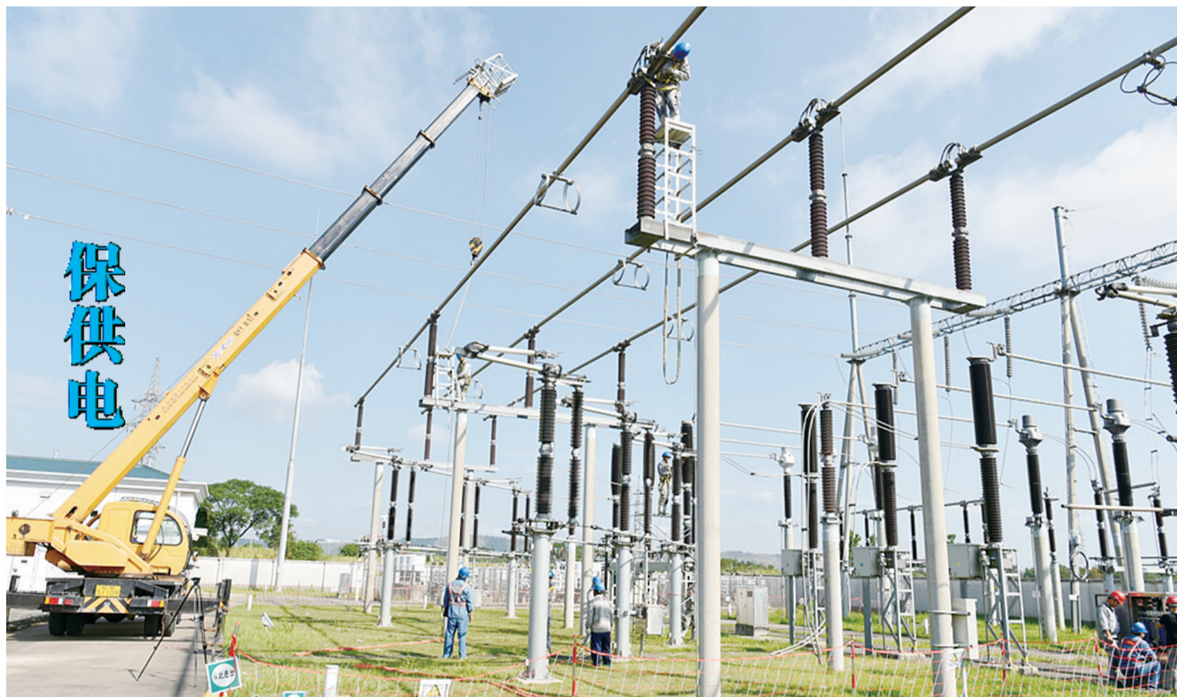
9月3日,国网安庆供电公司组织人员对宿松县220千伏黎河变电站进行改造。 此次改造不仅为宿松县政府重点工程220千伏雨福变电站顺利建设打下基础,也为安九高铁通车提供可靠电力保障。 沈新荣 摄
