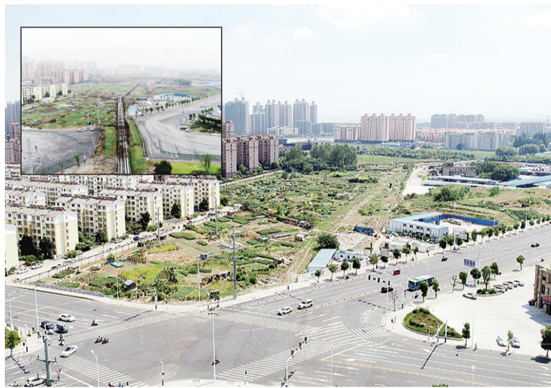
图为文苑路旧管廊带拆除前后对比。徐火炬 摄
