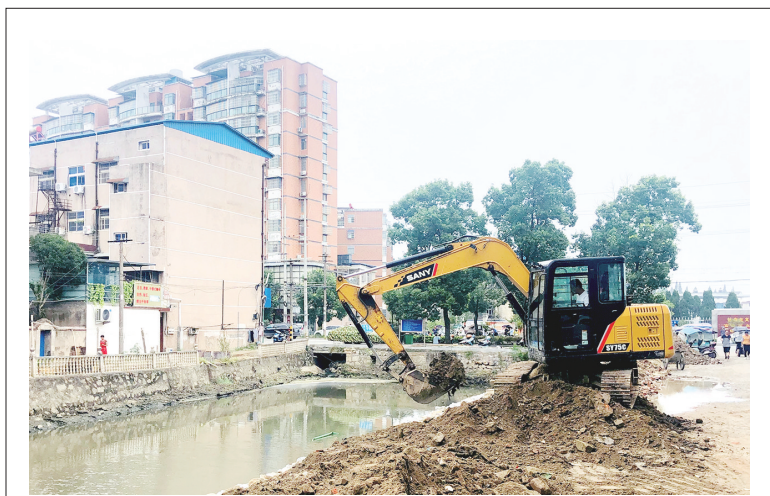
9月3日上午,施工人员正在对怀宁县石牌镇刁子河中段进行综合整治。连日来,怀宁县通过“截污治污、沟通水系、调活水体、营造水景、改善环境”等综合措施,大力推进城区水环境综合整治,持续改善城区内河水质,提升城市居住环境。 通讯员 钱续坤 张铁鑫 摄
