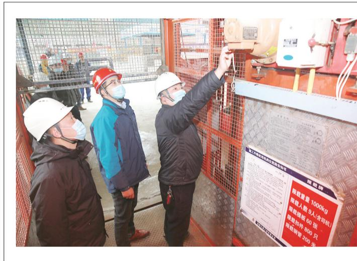
12月23日,市建管处安全监管人员在一建筑工地检查升降电梯安全制动器。
