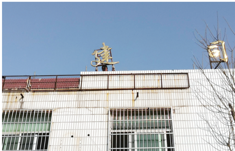
1月12日上午,工人对华中东路一建筑物天际线广告招牌进行拆除。
