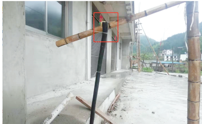
王正波家门前安装的自来水管。全媒体记者 朱柳 摄
