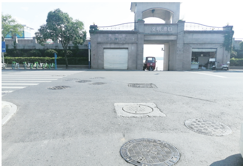
沿江路与大南门街交叉口处密密麻麻的窞井盖。
