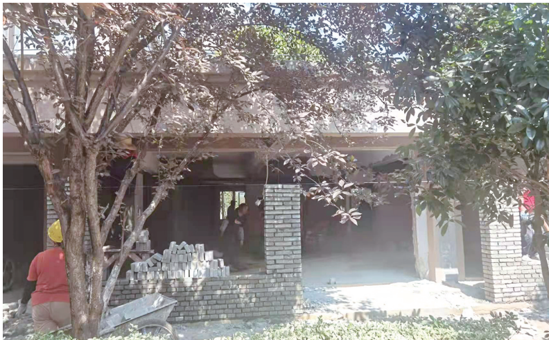
9月16日，小区12栋楼旁闲置用房正在装潢施工。
