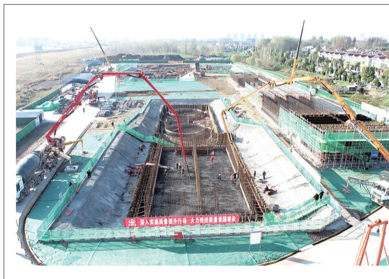
12月2日,望江城乡供水一体化工程施工现场,工人正在进行排泥池底板浇筑施工。
