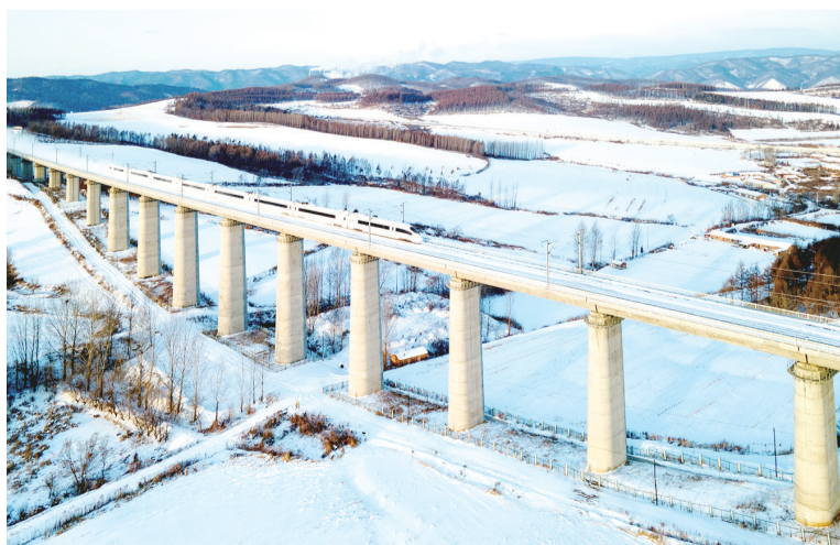
进行运行试验的牡佳高铁列车（12月2日摄）。 新华社发
