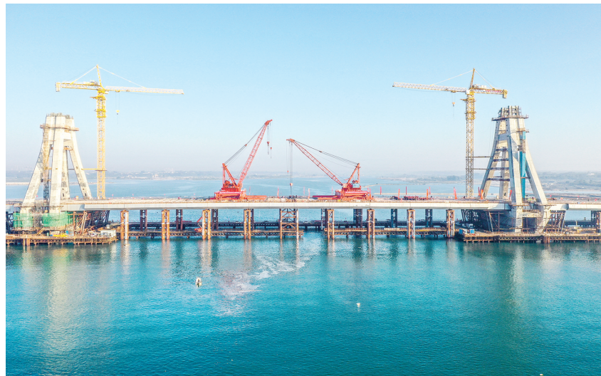
12月7日拍摄的西村港跨海大桥合龙现场(无人机照片)。
