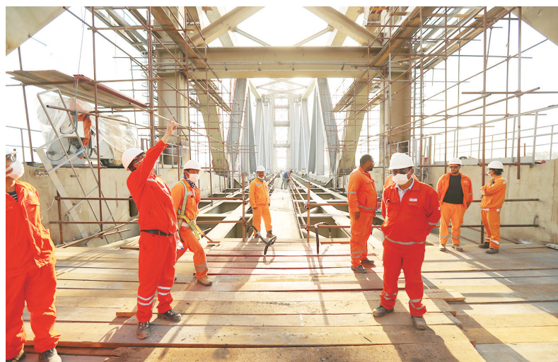
6月5日,在埃及伊斯梅利亚省,工人在苏伊士运河铁路桥旧桥改造升级项目施工现场作业。新华社发
