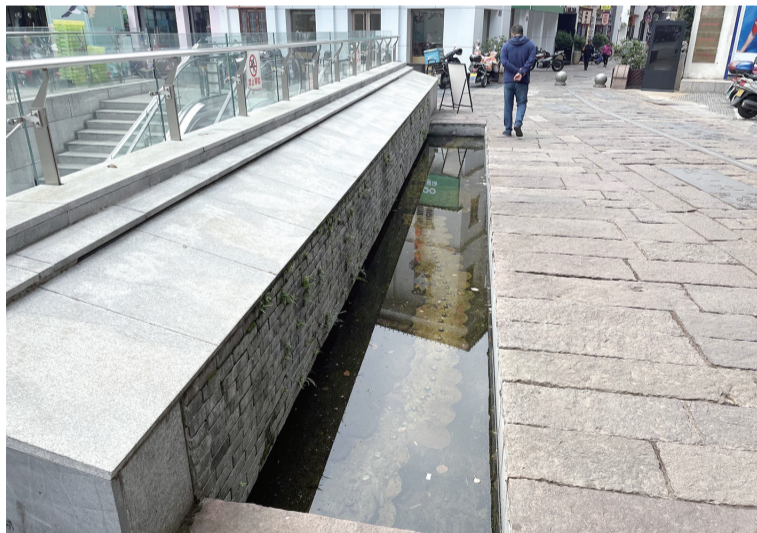
地下通道入口侧边的水池景观带。
