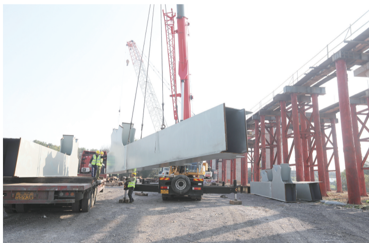
现场正使用汽车吊车装卸钢桁梁杆件。全媒体记者 徐火炬 摄
