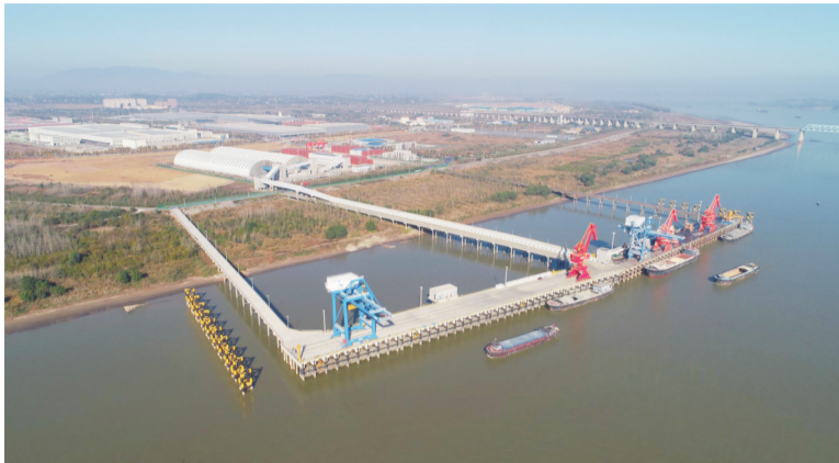
安庆港长风作业区二期工程。全媒体记者 路欣 摄
