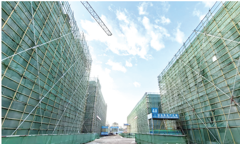
项目一期正在建设中。
