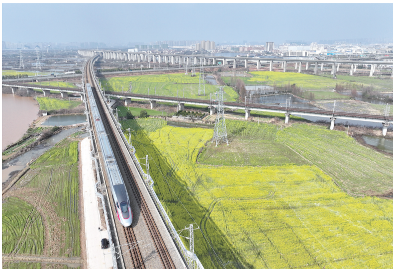
2024年3月2日，一辆高铁列车从江西省南昌市南昌县一处油菜花田旁驶过（无人机照片）。 新华社记者 金良快 摄
